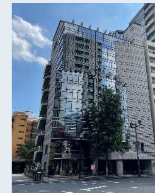
BIZIA Kojimachi Building
