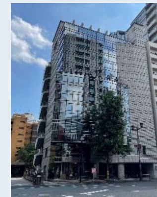
BIZIA Kojimachi Building
